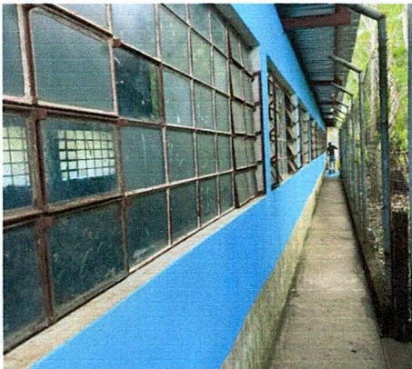
Foto 3: Mantenimiento y pintura de techo interior y exterior.
