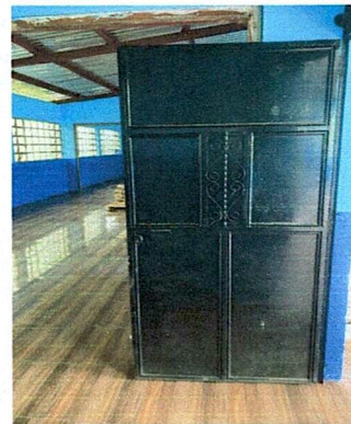
Foto 4: mantenimiento y reparación de puertas.
